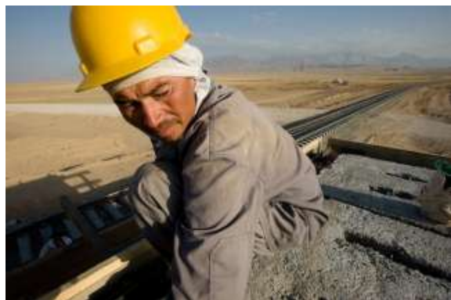
Construction d'une voie ferrée, Mazar-E-Sharif
