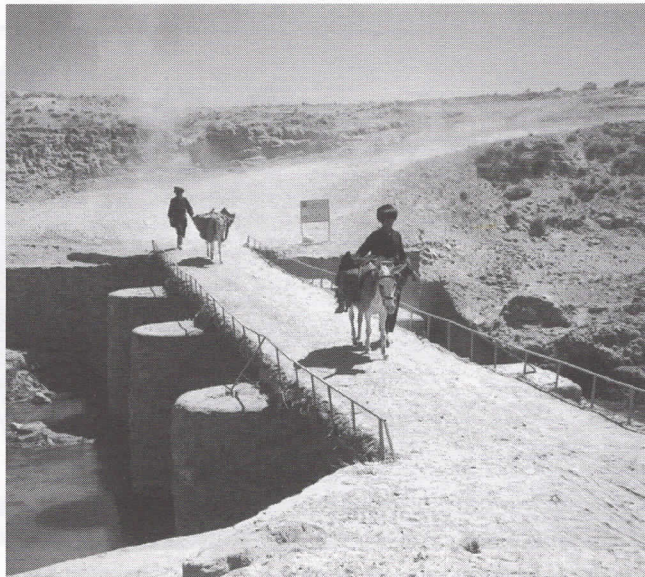
L'amélioration des routes et des infrastructures routières est décisive pour le développement des régions comme la reconstruction de ce pont. Photo Afrane
